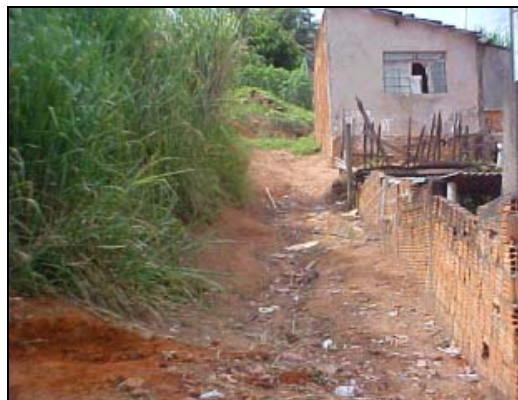
Foto 21 – Instalação de processo erosivo, na Vila Nova Prudente (Unidade Ambiental IV).
