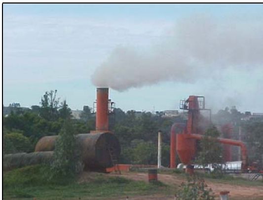
Foto 26 – Poluição atmosférica Encalco, localizada próxima ao trevo da Rodovia Júlio Budisk com a Avenida Miguel Damha.
