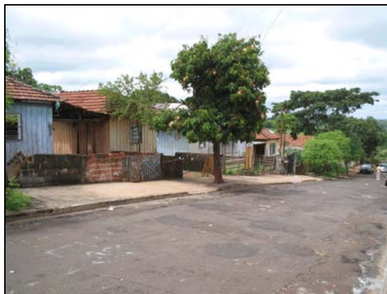
Foto 16 - Trecho da Vila Formosa, baixo padrão de construção. Várias residências em estado precário de conservação.
